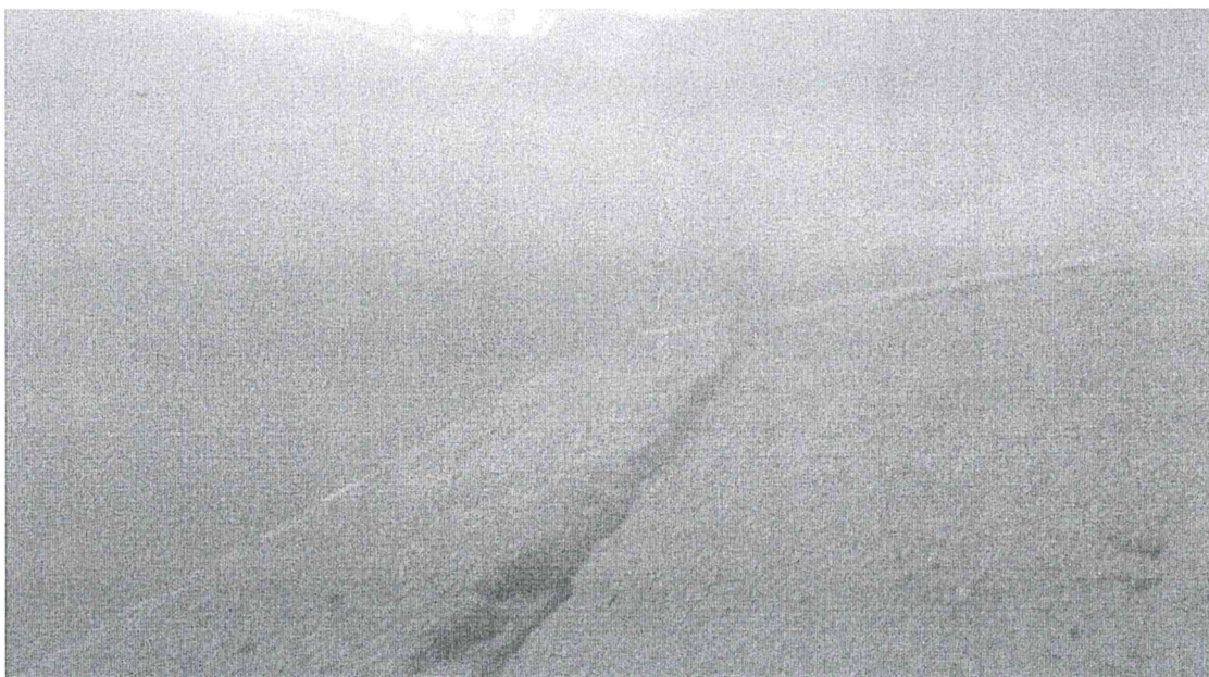
Fot. 14. Połączenie płyty żelbetowej skarpy odwodnej z przyczółkiem jazu – widoczna dylatacja (prawa strona)
