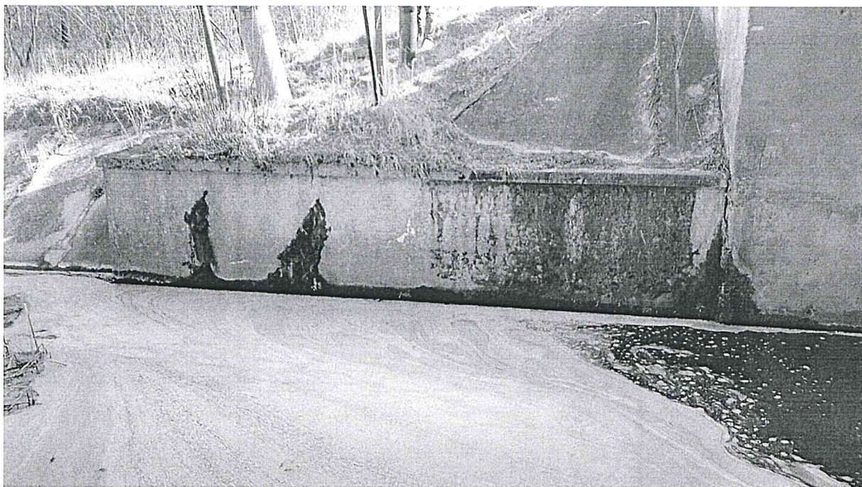
Fot. 25. Fragment prawego przyczółka jazu poniżej mostu (od WD) – widoczne wysięki wody na przyczółku i dylatacji.
