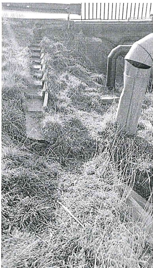
Fot.17. Brak prawidłowego odprowadzenia wód opadowych z odwodnienia drogi – dolny odcinek.
