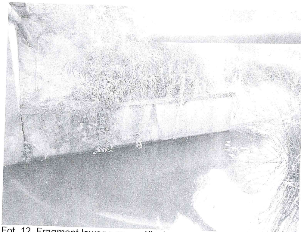
Fot. 11. Fragment prawego przyczółka jazu poniżej mostu (od WD) – widoczne wysięki wody na przyczółku i dylatacji.
