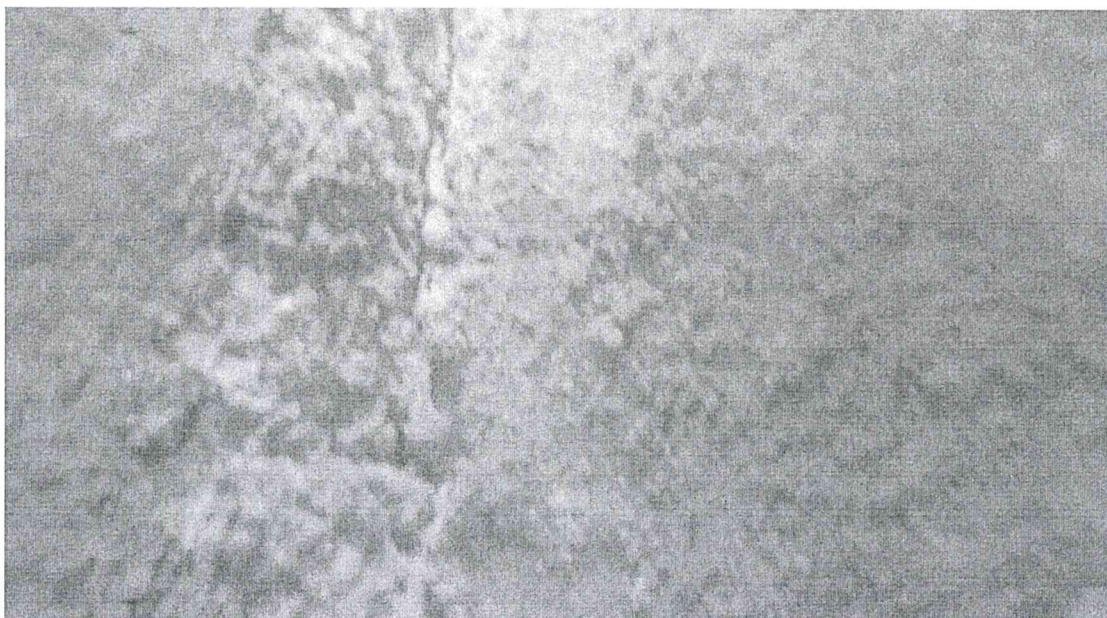
Fot. 2. Widok na dylatację lewego przyczółka jazu poniżej mostu (wykruszenie krawędzi płyt)
