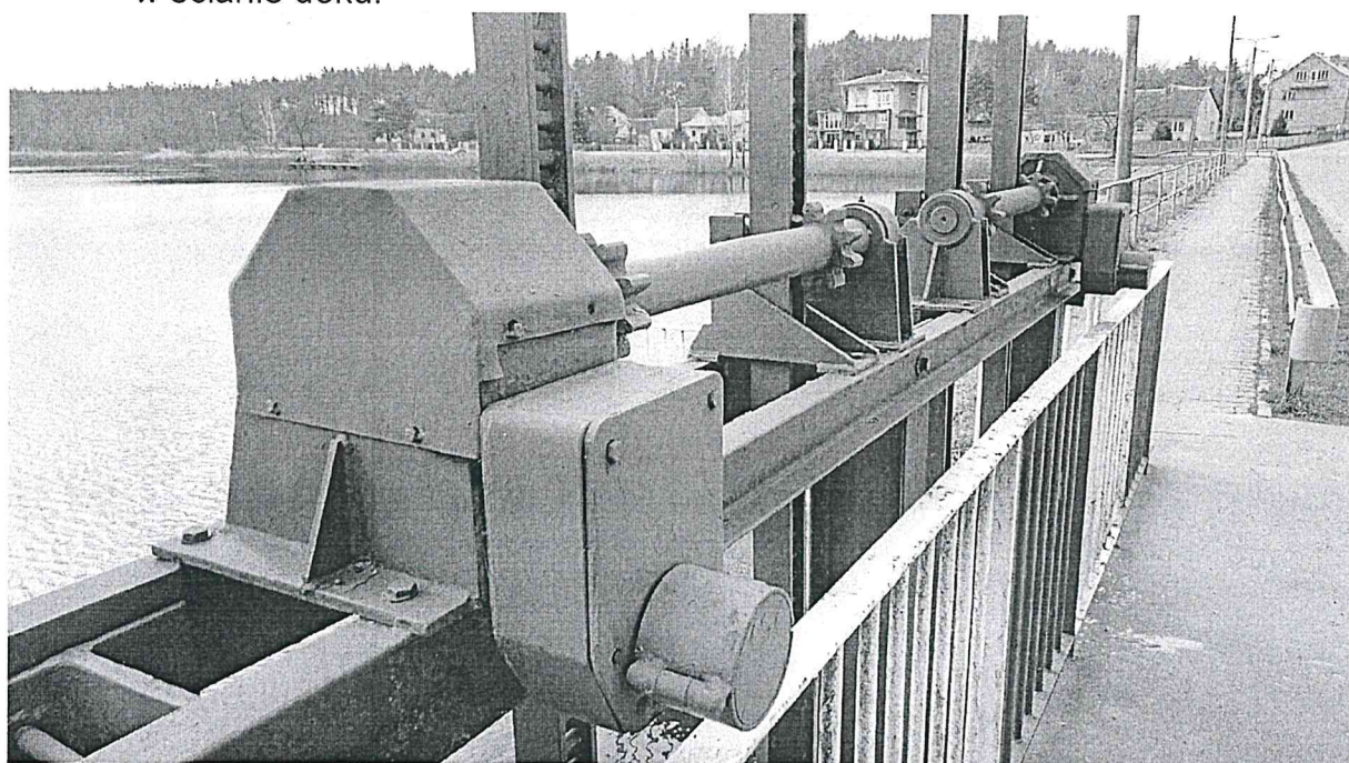
Fot. 22. Widok na mechanizm wyciągowy zamknięć jazu.
